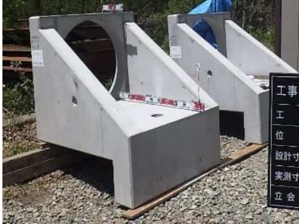
横断管渠吐口工
