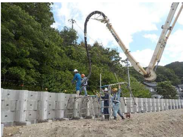
・中詰めコンクリート打設作業
