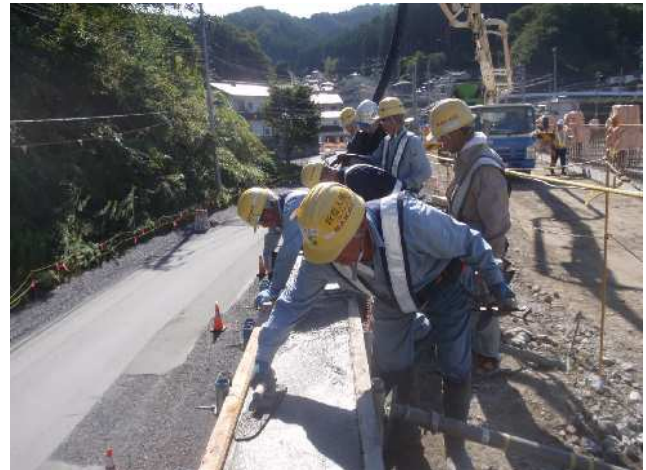
・天端コンクリート打設作業
