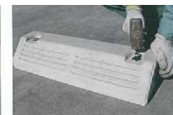
No.8 ボルトの叩き込み 締めしろ2~3mm残す
