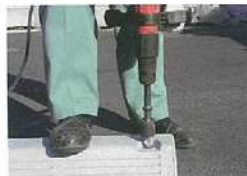
No.7 アンカーピンを叩き込み
