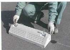
No.6 アンカーピンを挿入
