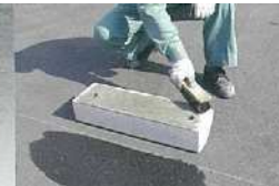
No.3 接着面の掃除及び水打ち
