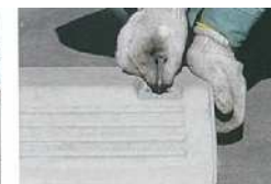
No.7 ボルトを挿入
