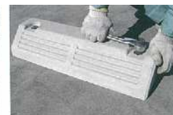
No.9 ボルトの締め込み
