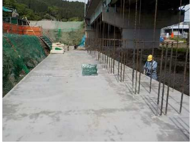
④中詰めコンクリート打設
