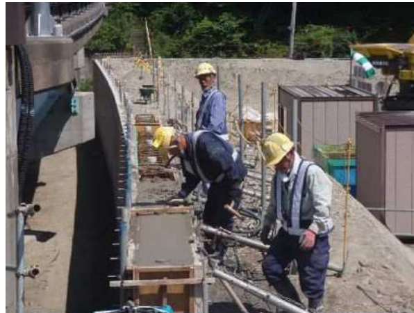
⑤天端コンクリート打設
