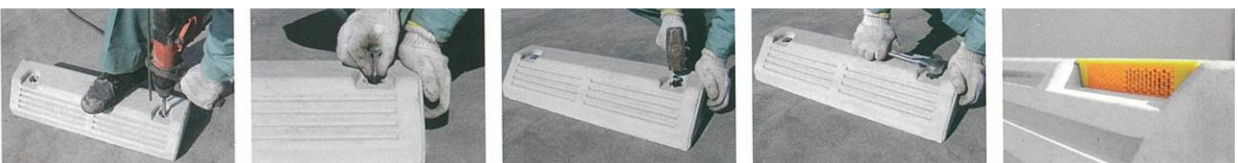
No.6 ドリルで穴あけ φ12深さ55mm以上 No.7 ボルトを挿入 No.8 ボルトの叩き込み 締めしろ2~3mm残す No.9 ボルトの締め込み No.10 位置決め ホールキャップをセット
