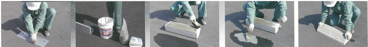
No.1 位置決め No.2 パーキングボンド練混ぜ No.3 接着面の掃除及び水打ち No.4 パーキングボンド塗布 No.5 ブロックをセット
