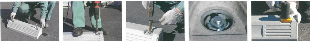
No.6 アンカーピンを挿入 No.7 アンカーピンを叩き込み No.8 ハンマーで叩き込み No.9 ホルダーの爪がアンカー頭部にかかるまで打ち込む No.10 ホールキャップをセット
