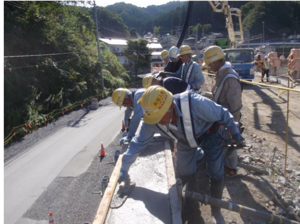
・天端コンクリート打設作業
