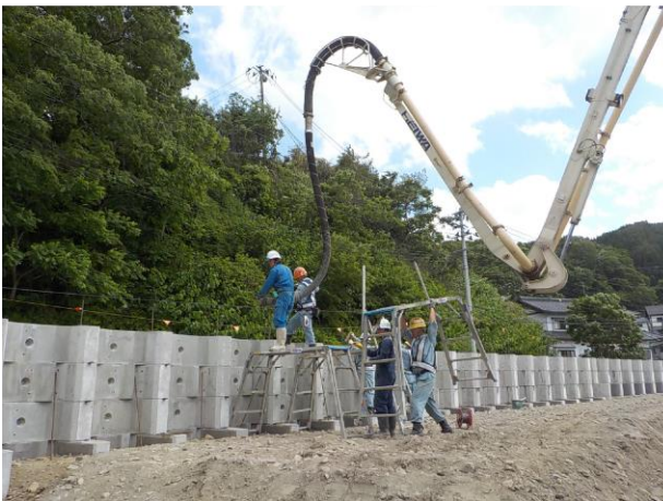
・中詰めコンクリート打設作業
